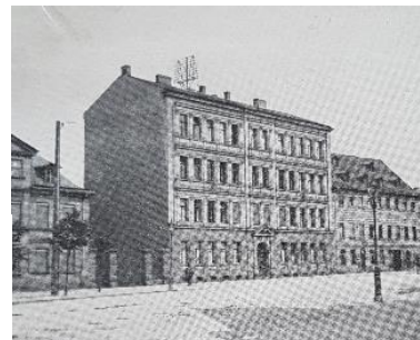
Das Schulgebäude an der Königstraße im Jahre 1896 – links daneben die damalige Stadtbibliothek mit der Dienstwohnung des Rektors im 1. Stock
